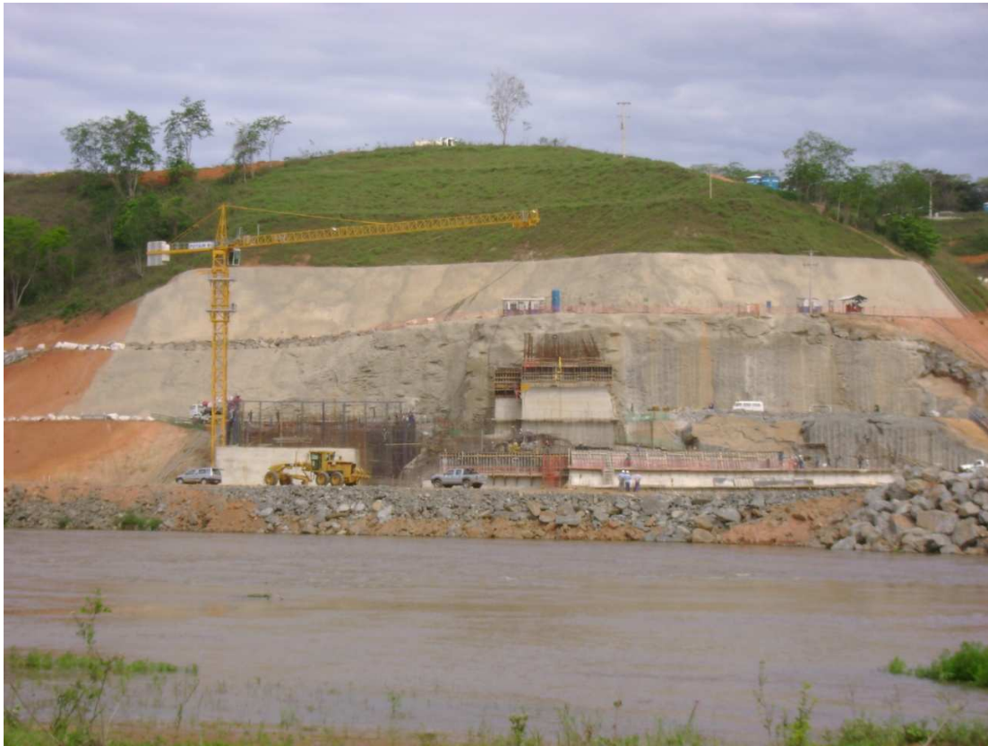
Foto: Obras da barragem da Usina Hidrelétrica Barra do Braúna. Julho/2009.
